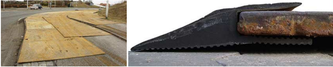
Figur 6.74. Eksempler på køreplader og gummirampe til køreplader
