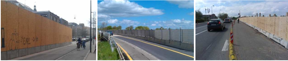
Figur 6.72. Eksempler på afskærmning mellem arbejdsområde og trafikområde
