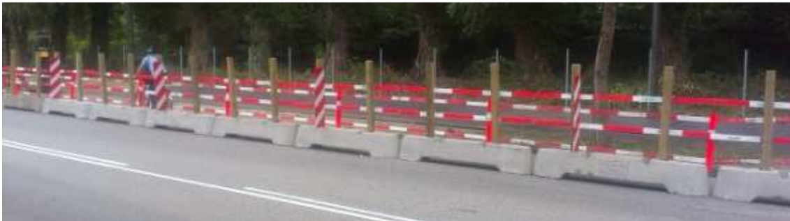
Figur 6.73. Eksempel på længdeafspærring med betonklodser
